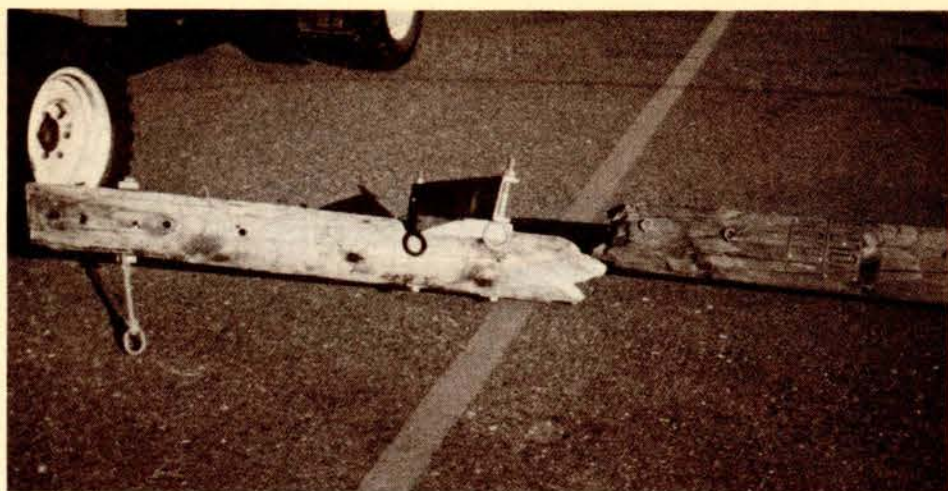
Broken pole in San Luis Obispo.
